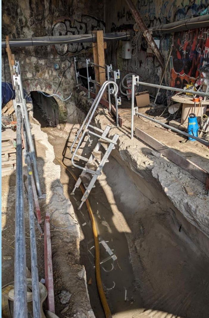
Ancienne route (encore en fonctionnement)
