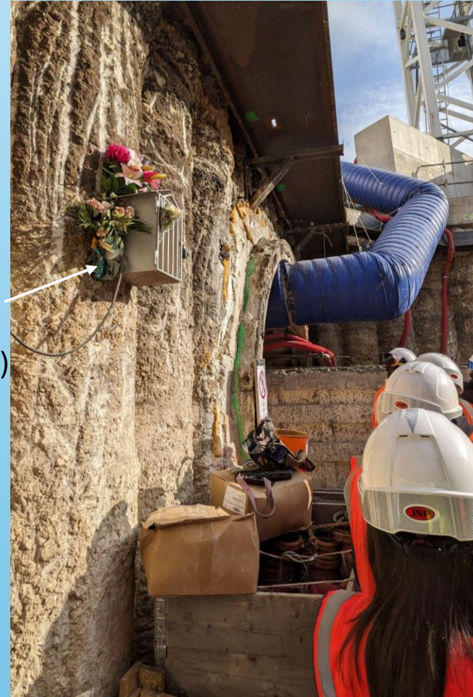
Entrée du tunnel
