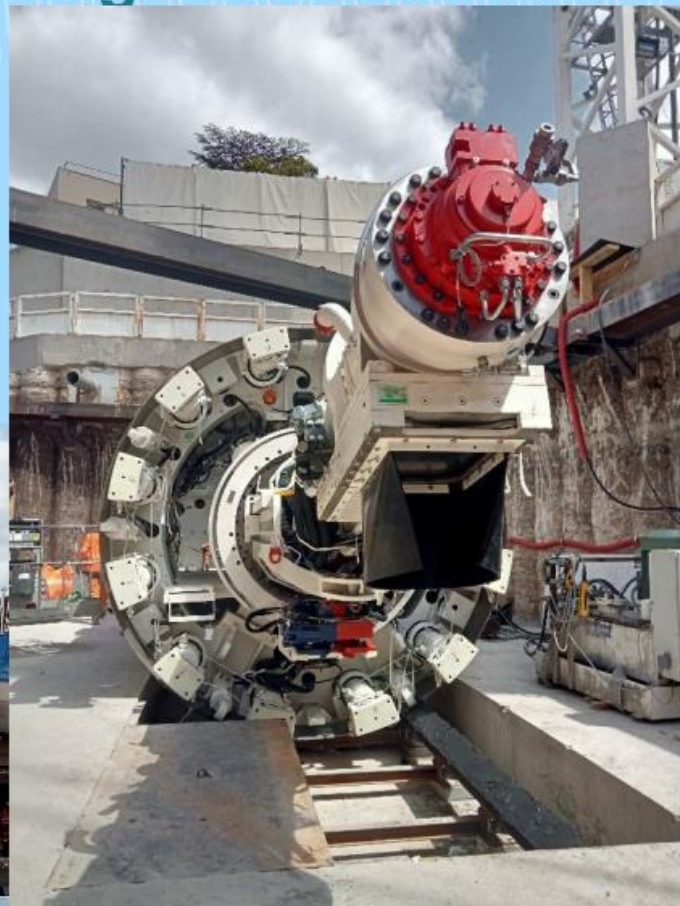
Puits Confluence – Montage Tunnelier
