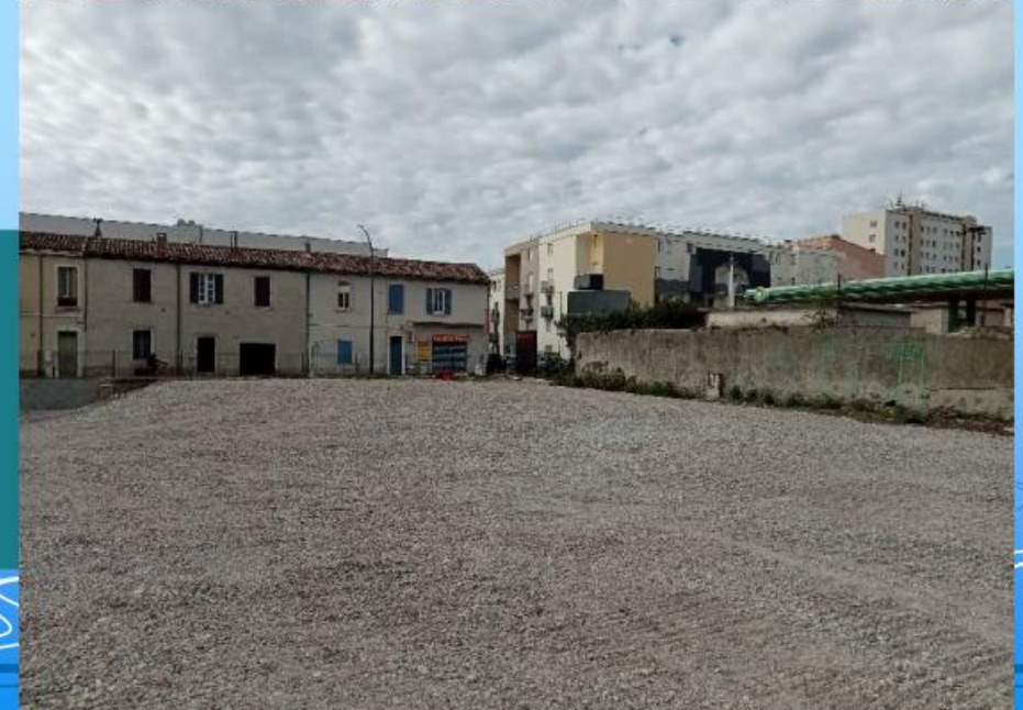
Etat plateforme avant installation base chantier
