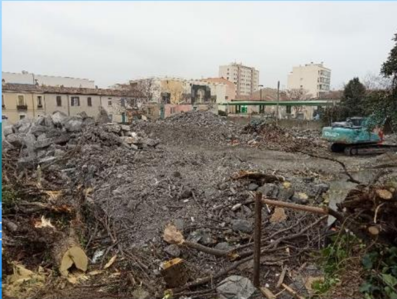
Démolition avant travaux
