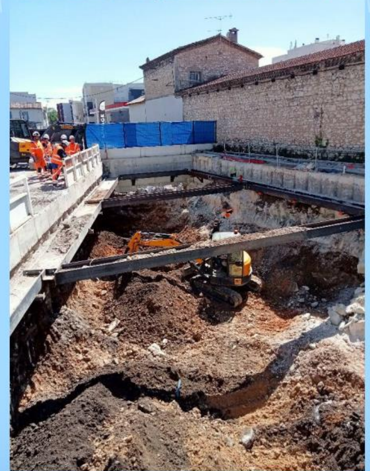
Terrassements du puits confluence (entrée du tunnelier)
