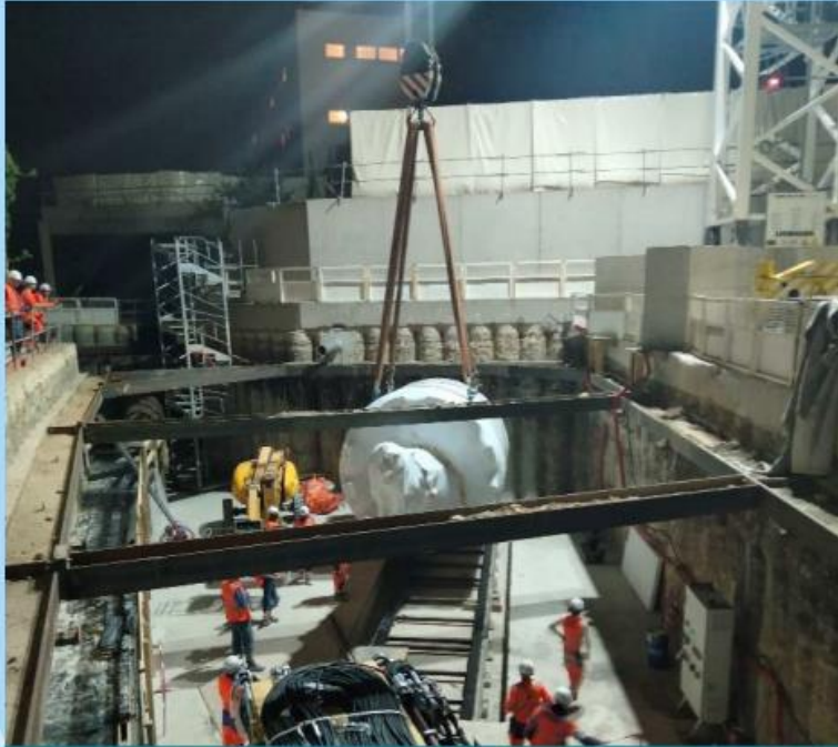
Puits Confluence – Montage Tunnelier
