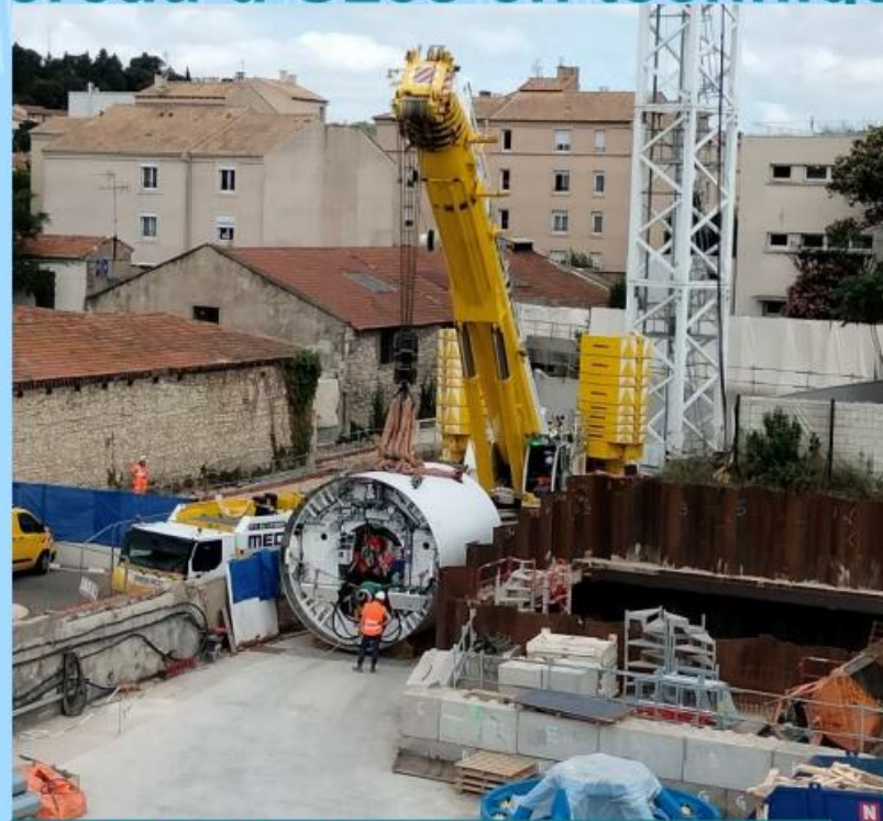
Puits Confluence – Montage Tunnelier
