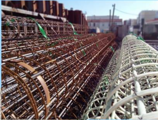
Cages armatures acier et fibres de verre pour pieux
